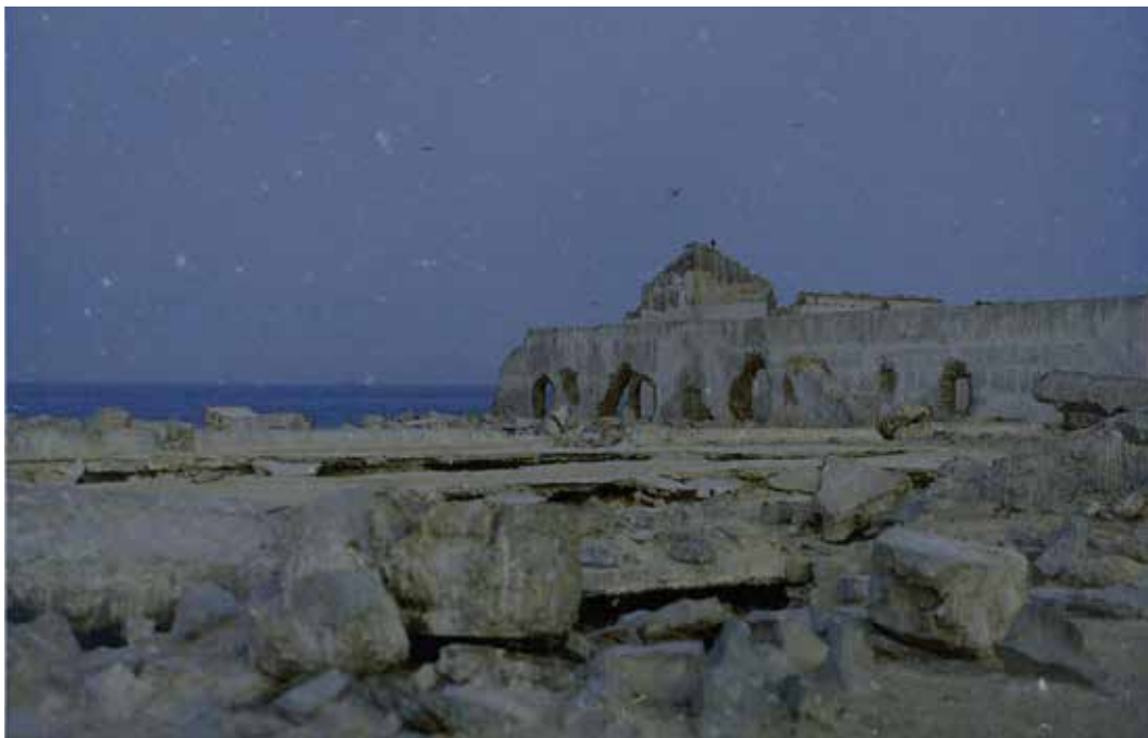
Fotografía N.º 4. Ruinas contemporáneas. Fuente: Fotografía de Handrez García Gonzales.
