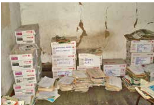
Fotografías N.º 3 y N.º 4. Labores de limpieza y colocación en cajas de cartón de la documentación. Fotografías: Juan Leandro Tito Melgar.
