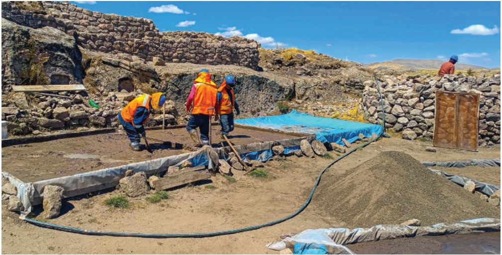
Imagen 10. Preparado de mortero de barro para los diferentes trabajos de restauración. Fotografía realizada por Emerson Pereyra
