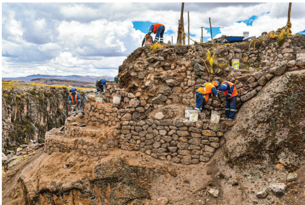
Imagen 14. Trabajos de recomposición y restitución en muros de contención ubicados en el sector C. Fotografía realizada por Emerson Pereyra
