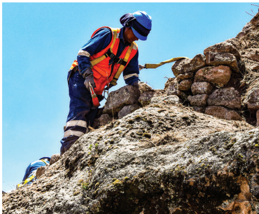
Imagen 5. Trabajos de restauración. limpieza y elinación de maleza en paramento. Fotografía tomada por Emerson Pereyra
