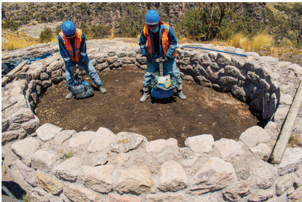
Imagen 9. Trabajos de tratamiento de piso, acción de apisonado y compactado. Fotografía realizada por Emerson Pereyra
