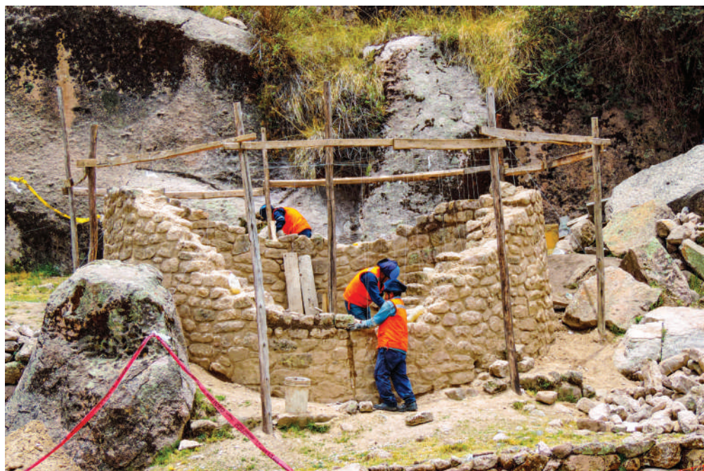
Imagen 7. Trabajos de restauración (consolidación y restitución) donde se aprecia el instalado de cruces. Fotografía realizada por Emerson Pereyra
