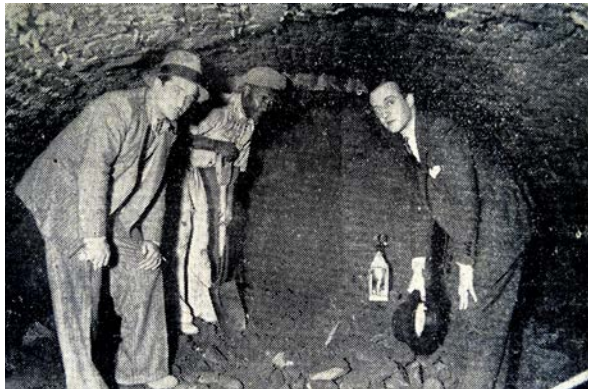
Imagen 2. Exploración en 1937 de la bóveda subterránea de la cual fueron extraídos los restos humanos en 1877. En Anónimo, “Los Incas enterrados en el antiguo Hospital de San Andrés”, Diario El Comercio , agosto 4, 1937”.
