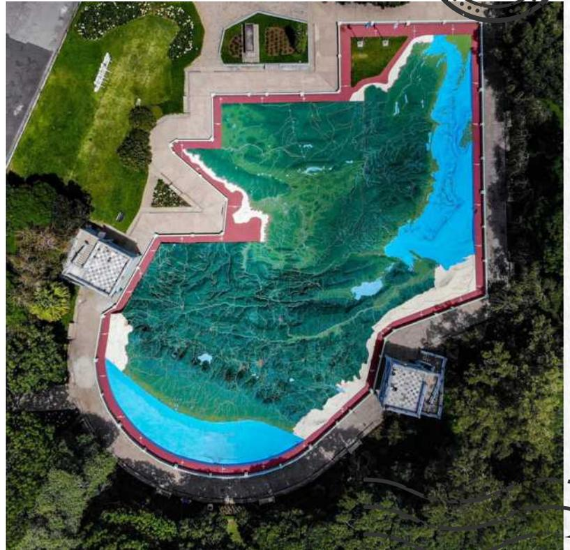
25,900 kilos (aproximadamente 57,099 libras) de cemento y 750 yardas (aproximadamente 685 metros) de tubería, contando en su interior con un depósito o "tinaco" para proveer de agua las costas, ríos, lagos y lagunas representadas (ver imagen 2).
