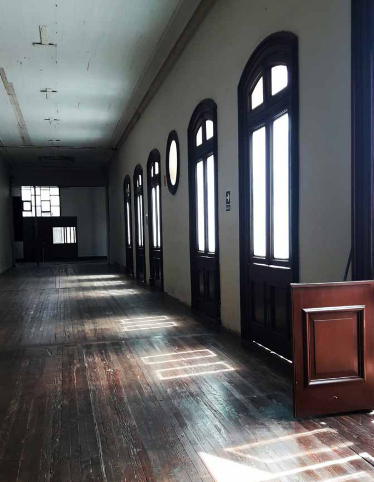
Pasadizo Casa de Correos (segundo nivel) Fotografía: Rosario Remigio
