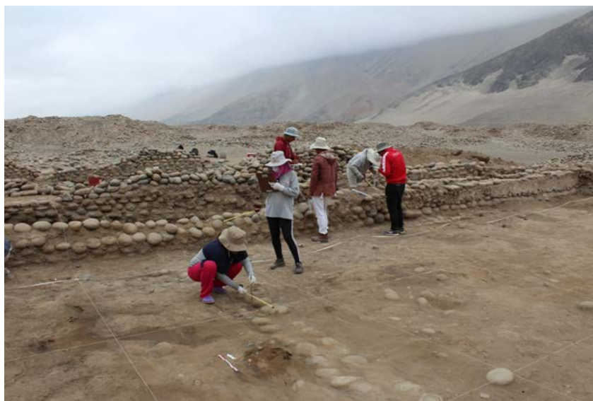
Figura 6. Cimiento de muro de cantos rodados expuesto al lado oeste de la estructura 1 de Tambo Viejo. El cimiento representa una primera fase de construcción, mientras que la estructura 1 representa una segunda fase.
